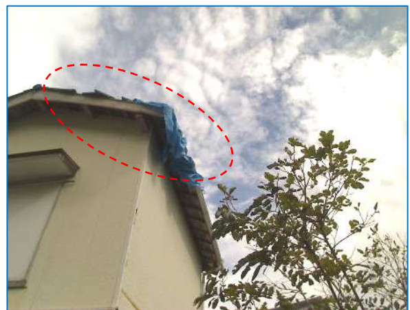
写真 撮影方向 東 屋根瓦の一部がめくれた住家
