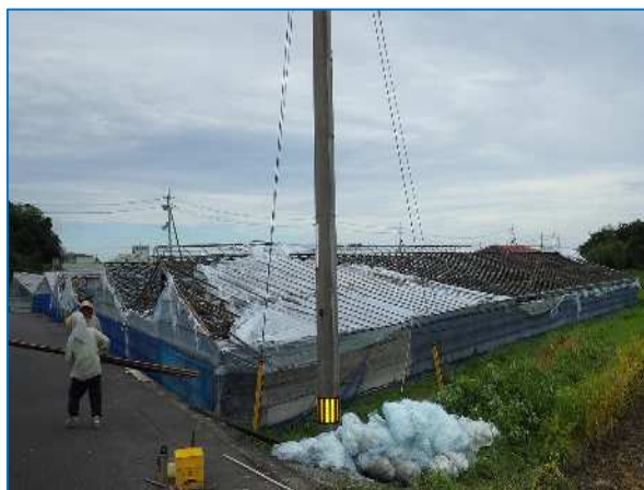
写真 撮影方向 南東 ビニールがめくれ、北東方向に飛散した 7 棟のビニールハウス
