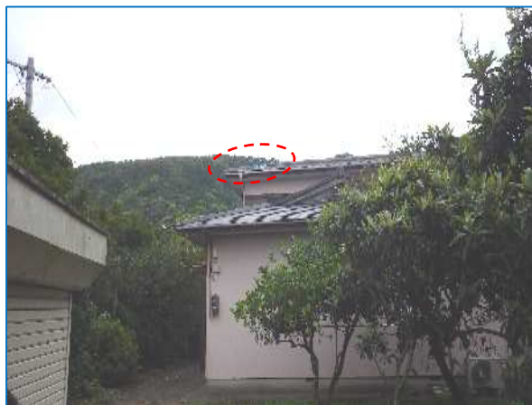
写真 撮影方向 北西 北東方向 40m に東面屋根の瓦が飛散した住家
