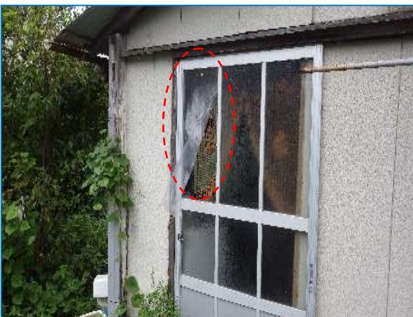
写真 撮影方向 北東 風圧で破損した(証言)住家西面の窓ガラス
