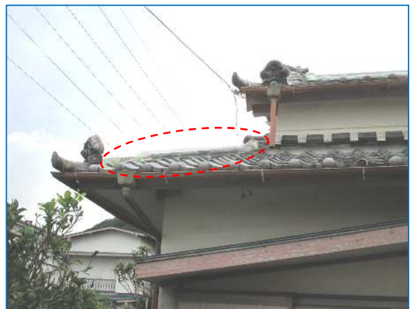
写真 撮影方向 北西 棟瓦の一部がめくれた住家
