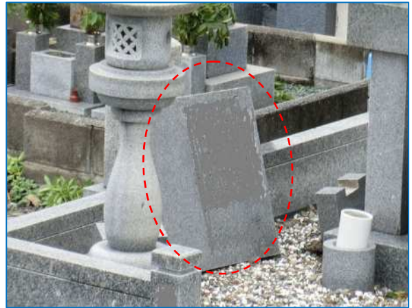
写真 撮影方向 西南西 東方向に倒れた墓碑
