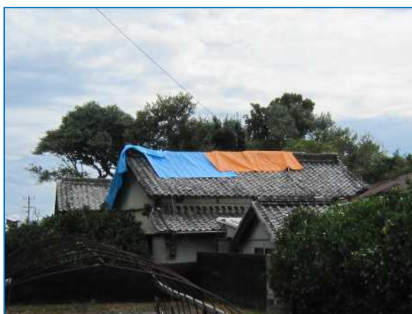
写真 撮影方向 南 屋根瓦が一部めくれた住家
