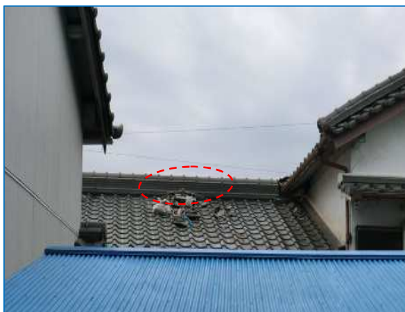
写真 撮影方向 南 屋根瓦の一部がめくれた住家
