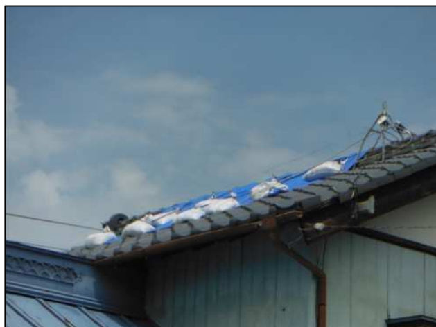
屋根瓦がめくれた住家、破損したアンテナ
