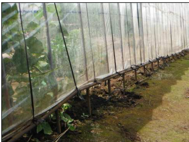
支柱が浮き上がったビニールハウス
