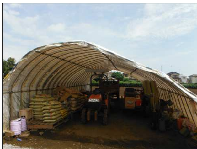
変形したビニールハウス
