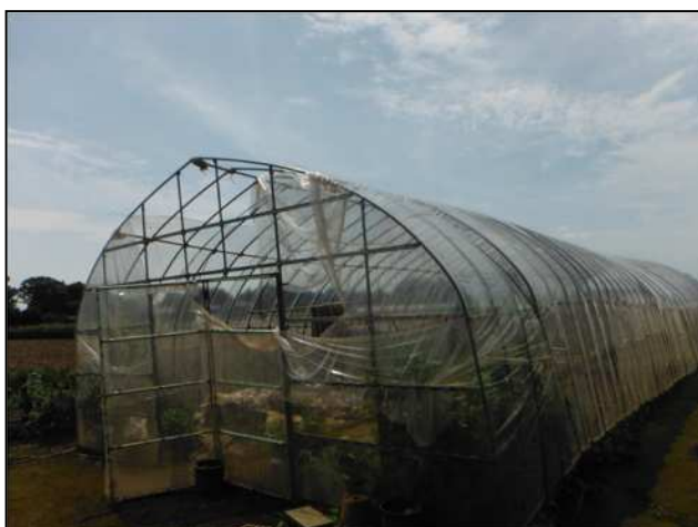
一部が損壊したビニールハウス
