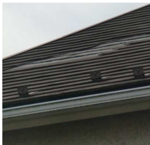
スレート瓦がめくれた住家 【東から撮影】
