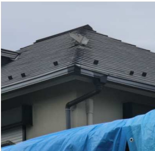
スレート瓦がめくれた住家 【南から撮影】
