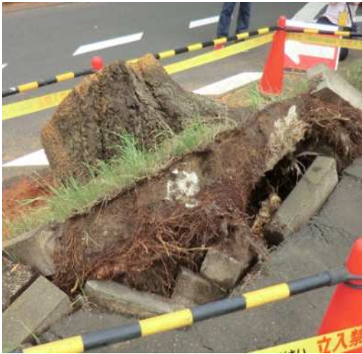
倒れた樹木の根元【南西から撮影】
