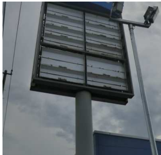
破損した看板【北から撮影】
