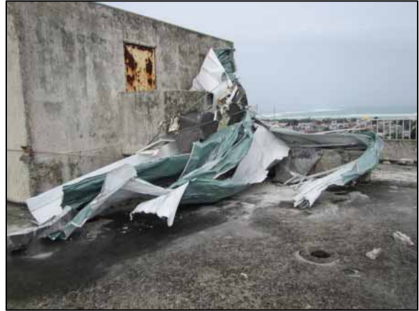
被害[10]飛散し、落下した屋根のトタン (大浜中学校屋上、北側から撮影)
