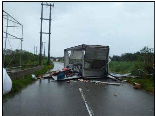
被害[17]飛散したプレハブ小屋 (南側から撮影：石垣市提供)
