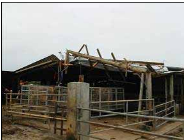
被害[18]屋根が飛散し、牛1頭が死亡した牛舎 (南東側から撮影)
