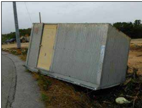
被害[15]飛散したプレハブ小屋 (南側から撮影)
