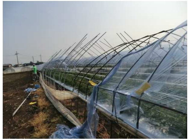
④ 一部が損壊したビニールハウス (北から撮影)
