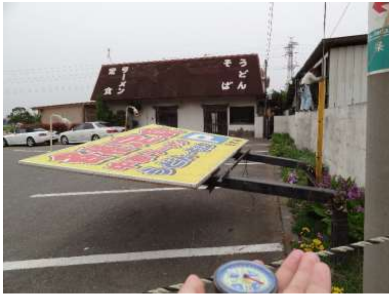
DOD=2 広告板の倒壊
