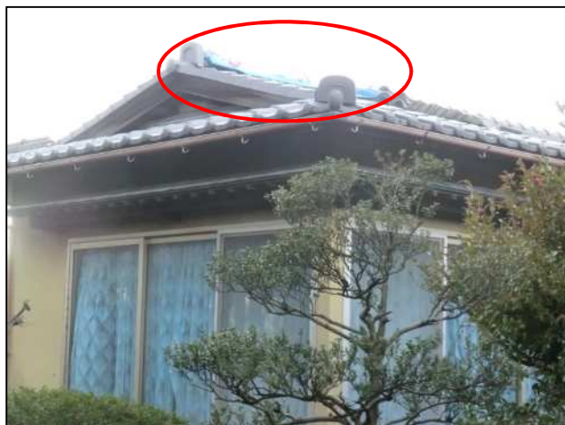
屋根瓦のめくれや落下があった住家 【南東方向から撮影】
