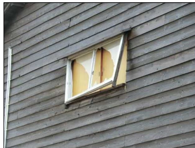
窓枠が損壊した非住家 【北西方向から撮影】
