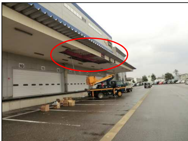
庇のスレート板のめくれや落下があった 倉庫【西方向から撮影】
