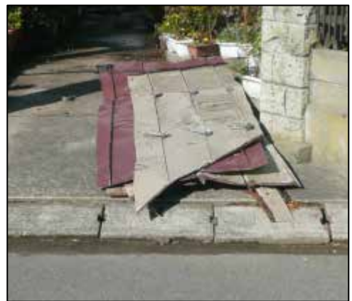
東側に約 20m 飛ばされた屋根 のトタンを回収し、門前に置い たところ(南東から撮影)
