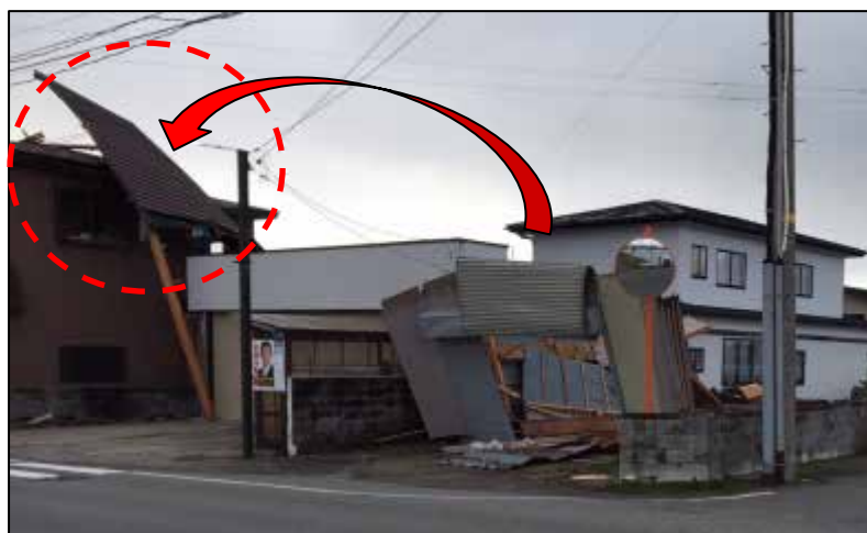
倒壊した物置小屋(北から撮影)
