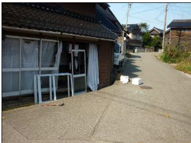
サッシがはずれガラスが破損した住家 【東方向から撮影】(志賀町役場提供)
