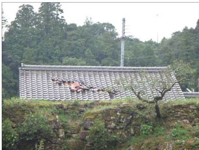
屋根瓦がめくれた非住家（北から撮影）
