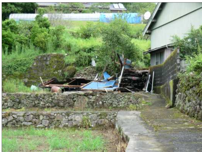
倒壊した納屋（南から撮影）
