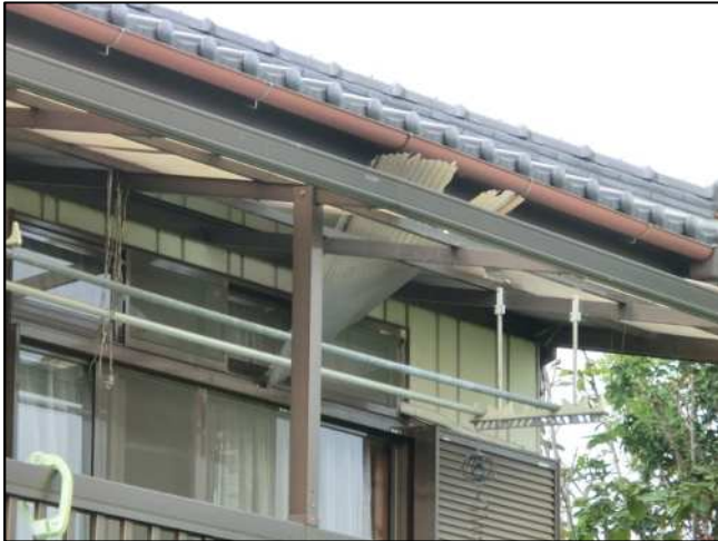
飛散した住家ベランダの屋根 (南西から撮影)
