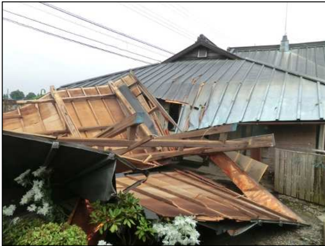
飛散した非住家の屋根 (北から撮影)
