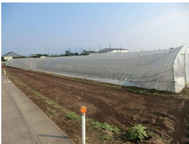
一部が損壊したビニールハウス (北から撮影)
