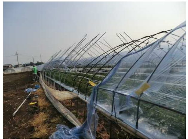
一部が損壊したビニールハウス (北から撮影)
