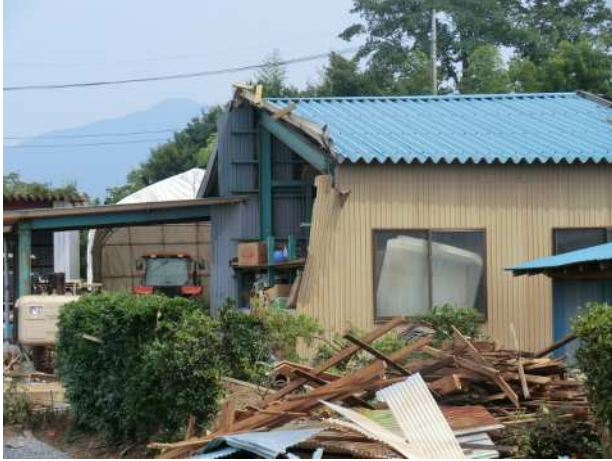
損壊した非住家 (北西から撮影)
