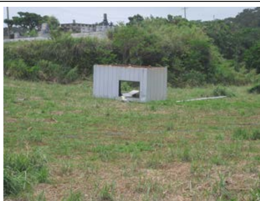
⑦イ地区：北西方向へ約 17m 吹き飛ばされたプレハブ小屋
