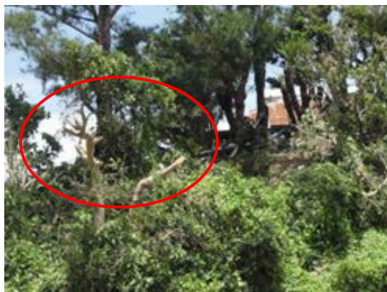
①ア地区の南端：幹折れした樹木 （南から撮影）
