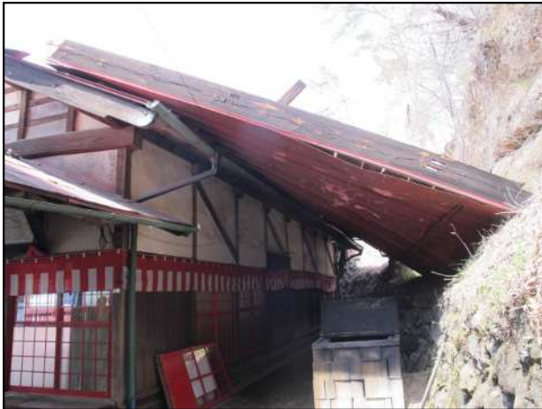
トタン屋根が飛散した神社
