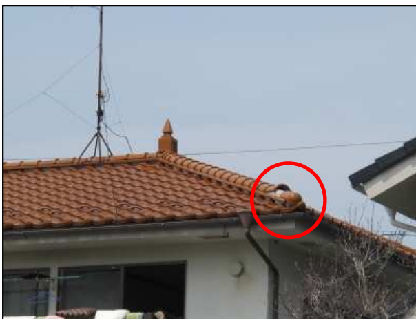
屋根瓦が落下した住家
