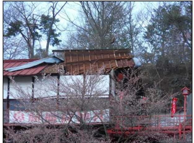
トタン屋根が飛散した神社
