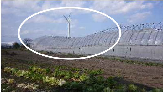
変形したビニールハウス。
