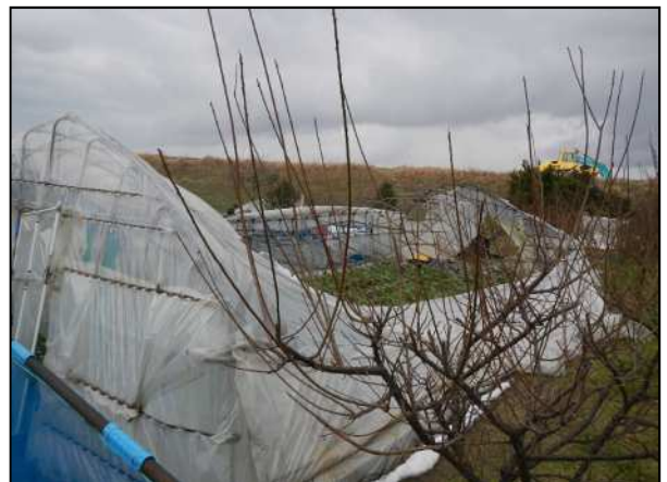
倒壊したビニ - ルハウス (南東から撮影)
