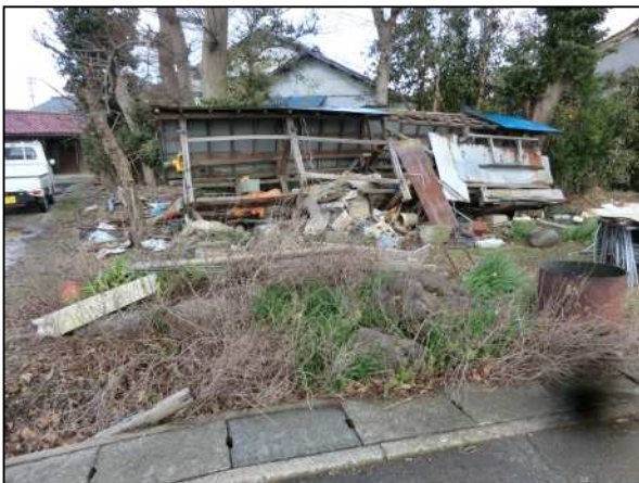
倒壊した物置小屋 (南から撮影)
