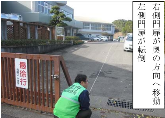
図 3-3 写真③ 転倒及び約 30m 移動した小学校の門扉（幅 2.8m、車輪あり）
