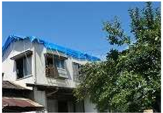
屋根が飛ばされた住家
