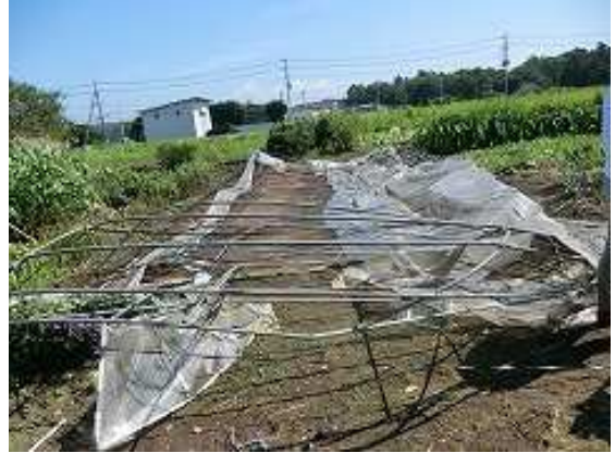
倒壊したビニールハウス
