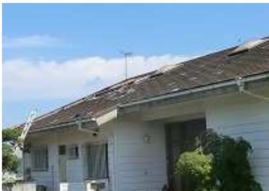
スレート屋根瓦がめくれた住家
