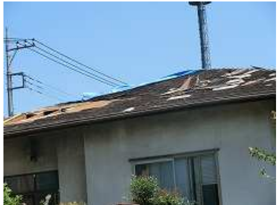
スレート屋根瓦がめくれた住家
