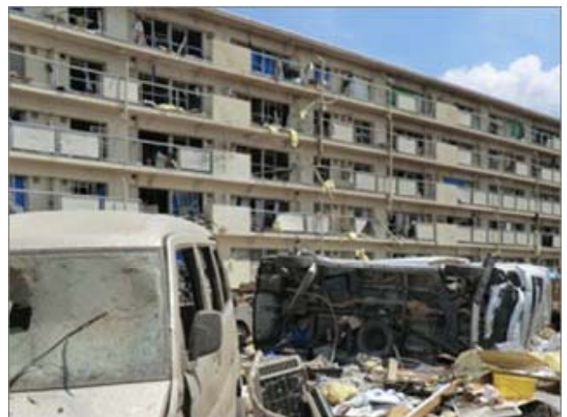
④ 飛散物により被害を受けた住宅等 （つくば市北条）
