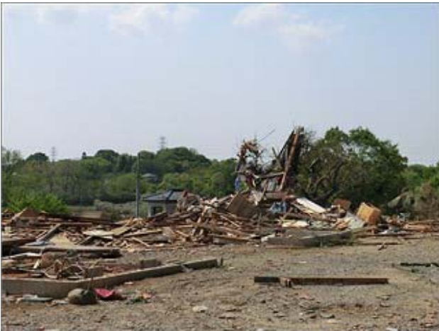
③ 全壊した家屋 （つくば市山木）
