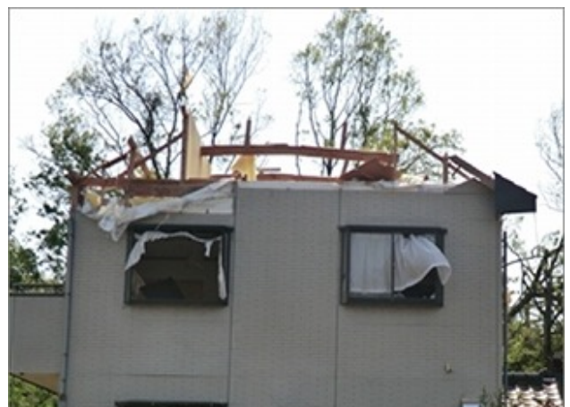
⑥ 屋根が吹き飛ばされた住宅 （つくば市北条）
