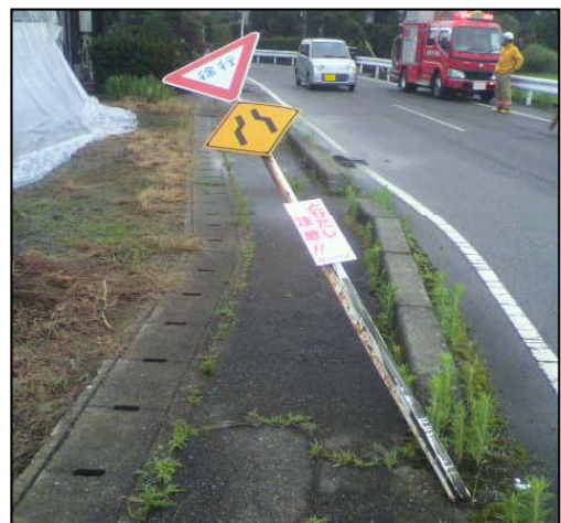
⑥三条市 傾いた道路標識（南西から撮影） 【三条市役所提供】
