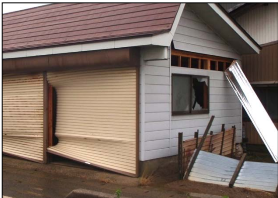
⑤三条市 シャッター、窓、外壁等の被害 があった家屋（南東から撮影） 【三条市役所提供】
