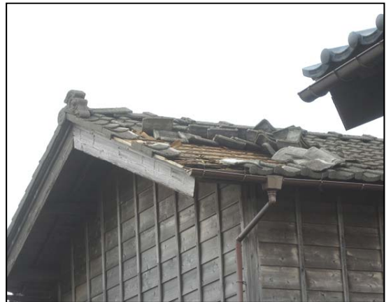
④三条市 めくれた屋根瓦（南西から撮影）
