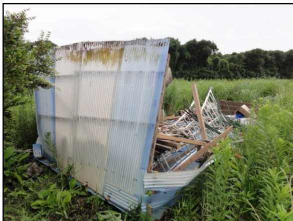
⑨小屋の倒壊(東から西に飛ばされる)
