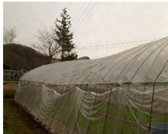
⑫ 東側に変形したビニールハウス (南西から撮影)
