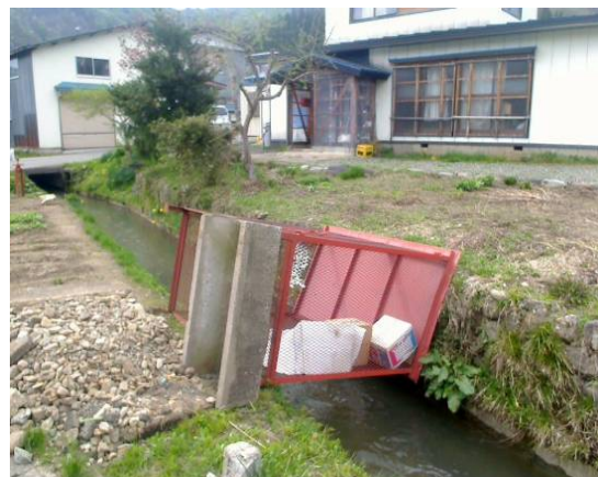
⑥ 北に倒れたごみ集積庫 (東から撮影)
