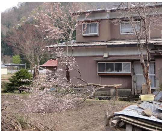
⑤ 北方向に折れた桜の木(直径約10 cm) (北西から撮影)
