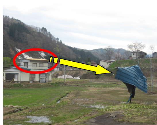
⑩ 北東方向に約 60m 飛散し、電線に 引っ掛かった住家のトタン屋根 (東北東から撮影)
