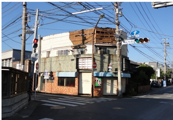
①破損した壁と曲がった標識 【南東から撮影】
