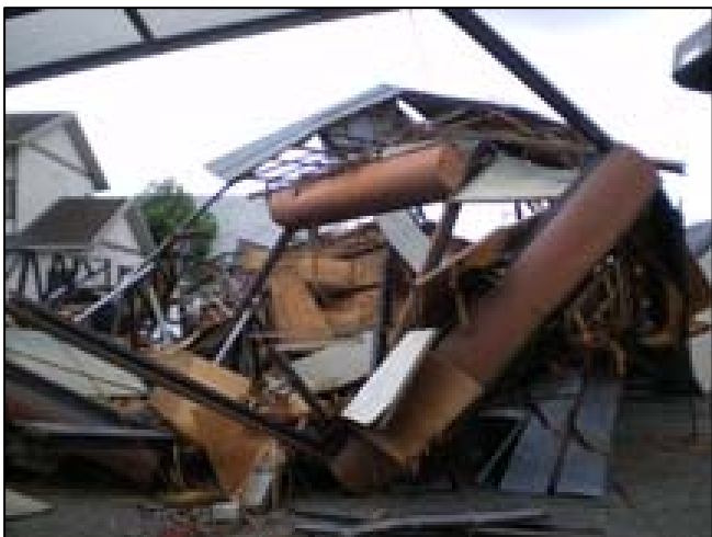
⑤ 倒壊したプレハブ小屋（南西から撮影）
