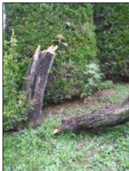
⑥ 折損した樹木（南東から撮影）
