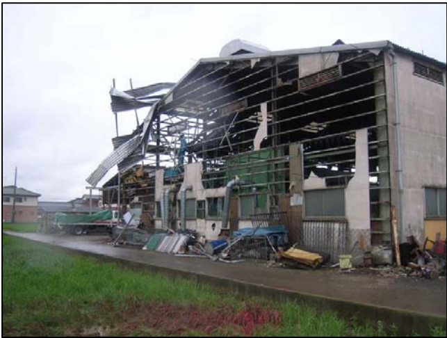
③ トタン屋根や壁が剥離及び飛散した工場（北東から撮影）
