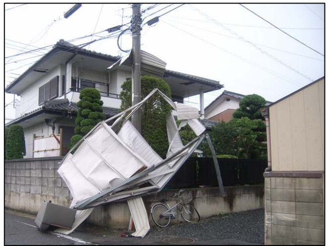
④ 風で飛ばされたプレハブ物置（南西から撮影）
