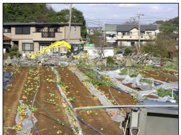
⑥ 倒壊したビニールハウス【南南東から撮影】
