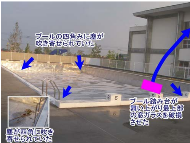
3 プール踏み台が舞い上がり窓ガラスを破損
