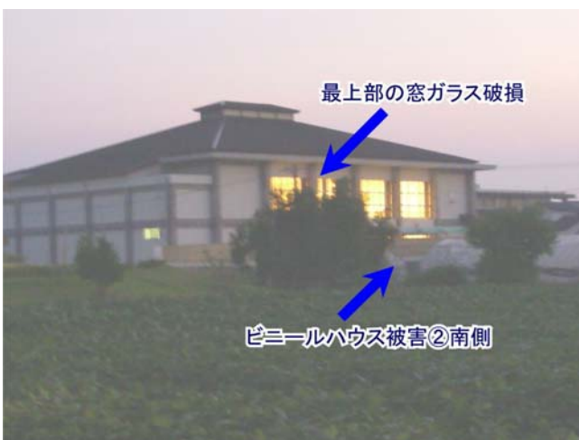
5 体育館窓ガラス破損
