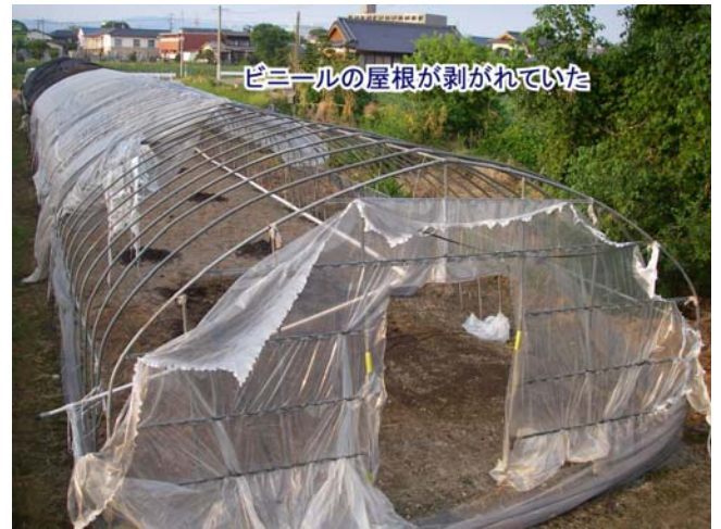
2 ビニールハウス被害②南側
