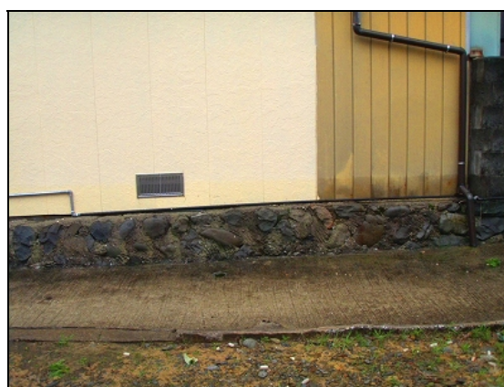
地点2：浸水の痕跡
