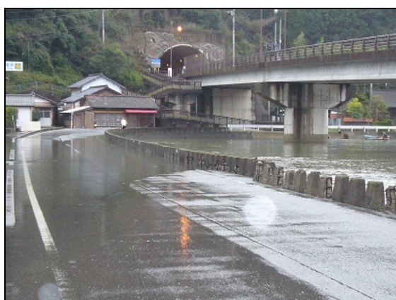
地点1：2月25日08時40分頃の道路の冠水
