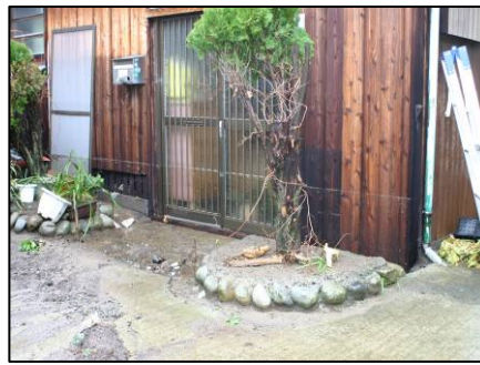
地点 2：上甌町瀬上での床下浸水
