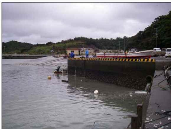
25日 08時40分（副振動の引き潮時） （薩摩川内市役所上甑支所提供）
