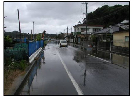
地点 3：上甌町小島の道路冠水
