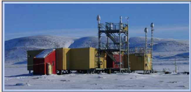
ニール・トリベット GAW 観測所、アラート(カナダ)
