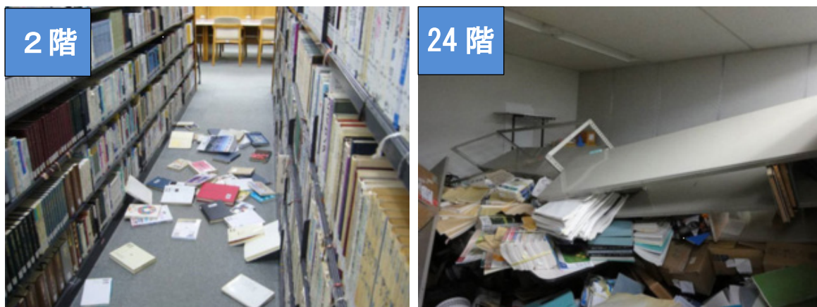
図2 東京都内の同じビル内での被害の違い（工学院大学提供）
