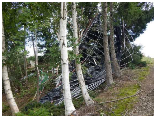
①パイプハウスの倒壊
